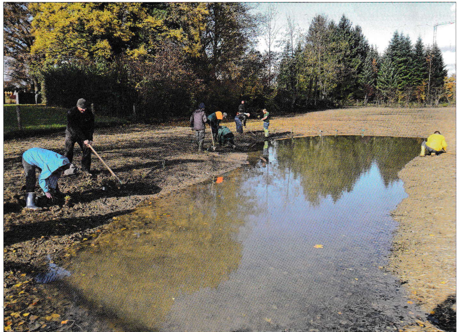
Der neu angelegte Weiher beim Friedhof Awandel füllt sich zu Feuchtzeiten mit Grundwasser und wird durchs Jahr hinweg zwischendurch auch trockenliegen. (pw)
